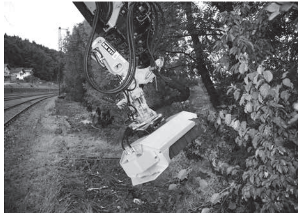
SLA 4 montiert am Manipulator (Kranarmbau)
