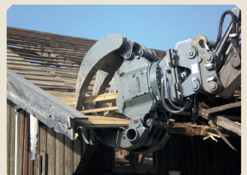
Unschlagbar für den Abbruch von Holzkonstruktionen: D20H-T 5-Finger-Holzgreifer
