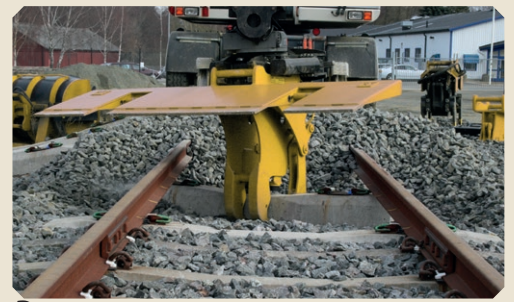
Der Bahnschwellenwechsler RBS entfernt und positioniert Bahnschwellen bei bereits angelegten Schienensystemen
