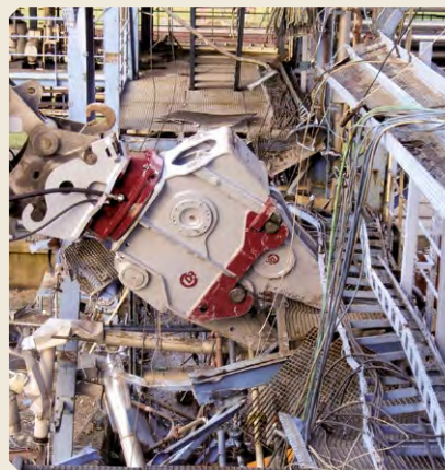
Dank auswechselbarer Schneidbacken ein universeller Zerkleinerer: Der MQP Multi-Quick Processor, hier mit Stahl-Backen
